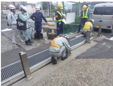
止水板の設置訓練の様子
