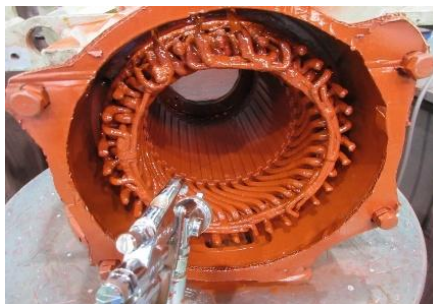
主電動機 (モーター) 絶縁更新 (東西線車両)
