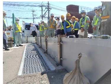
止水板の設置訓練の様子
