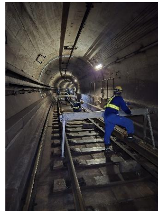
東西線のレール交換
