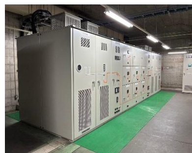
更新した電力設備（北山駅）
