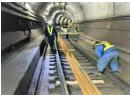
烏丸線のレール交換
