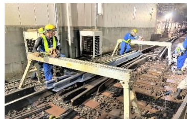
分岐器交換作業
