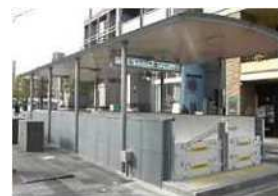
駅出入口の止水板
