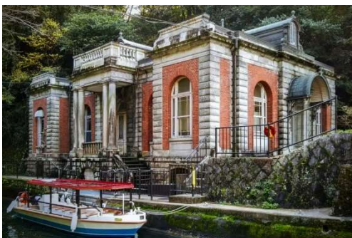
旧御所水道ポンプ室
