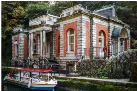
旧御所水道ポンプ室
