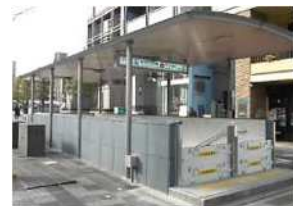
駅出入口の止水板
