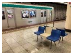
施工後のベンチ
