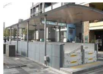
駅出入口の止水板
