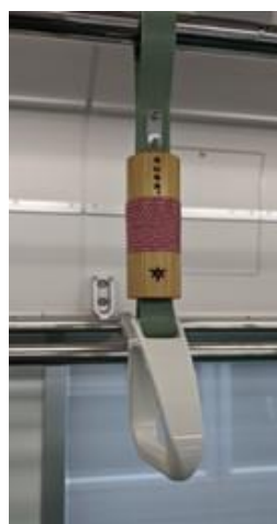
吊手の設置風景 （中間車両）
