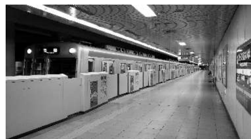
【可動式ホーム柵／烏丸御池駅】
