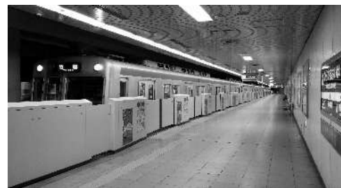
【可動式ホーム柵／烏丸御池駅】
