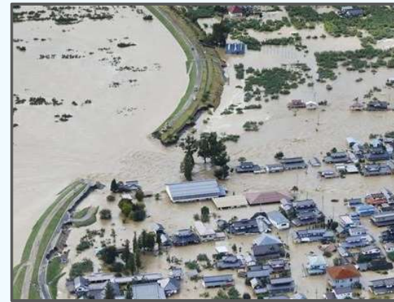
長野県千曲川堤防決壊による被害状況
