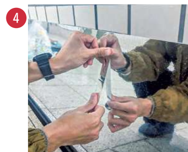
現場でミラーシートの継ぎ目をカバー。
