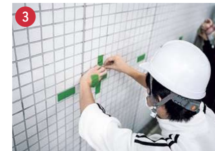
今出川駅の壁面に養生テープでパネル位置の印をつけ確認します。
