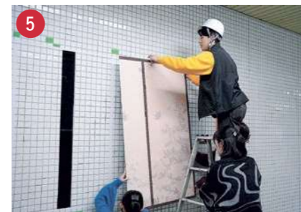
マジックテープを合わせ、メインパネルを固定します。
