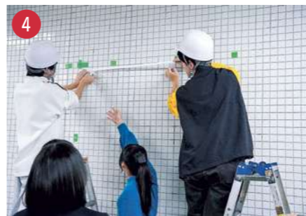
つけた印に合わせ、パネル側と対応するもう一方のマジックテープを壁面に貼り、位置を整えます。
