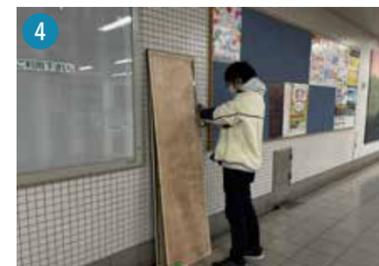
4 枠の壁との接着面にアクリル両面テープを貼る。
