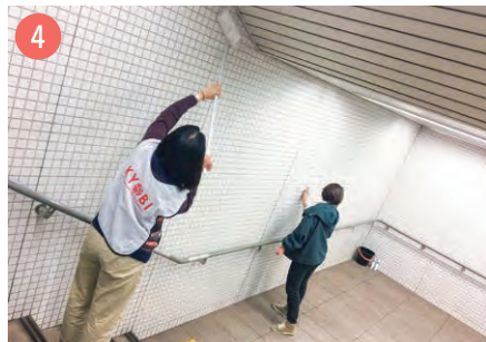
パネルを貼る前に壁の清掃をしました。
