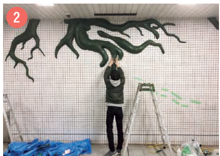
設置には厚手の両面テープとコンクリートビスを用いてしっかりと固定します。
