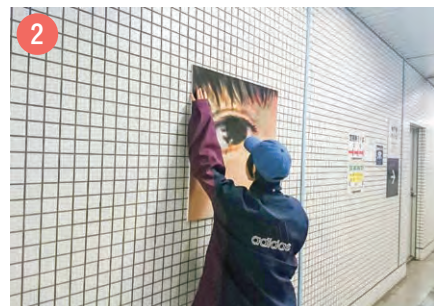
パネル出力し、強力両面テープを用いて設置します。
