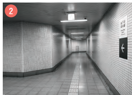
二条城前駅 「駅」には、白色蛍光灯が並ぶ。
