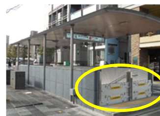
地下鉄出入口の止水板 (京都市役所前駅2番出入口)
