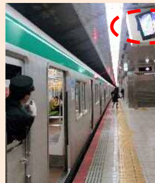
ホーム車掌用モニター 設備の増設
