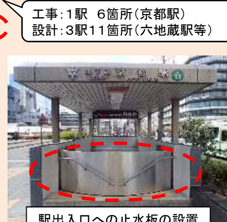
駅出入口への止水板の設置
