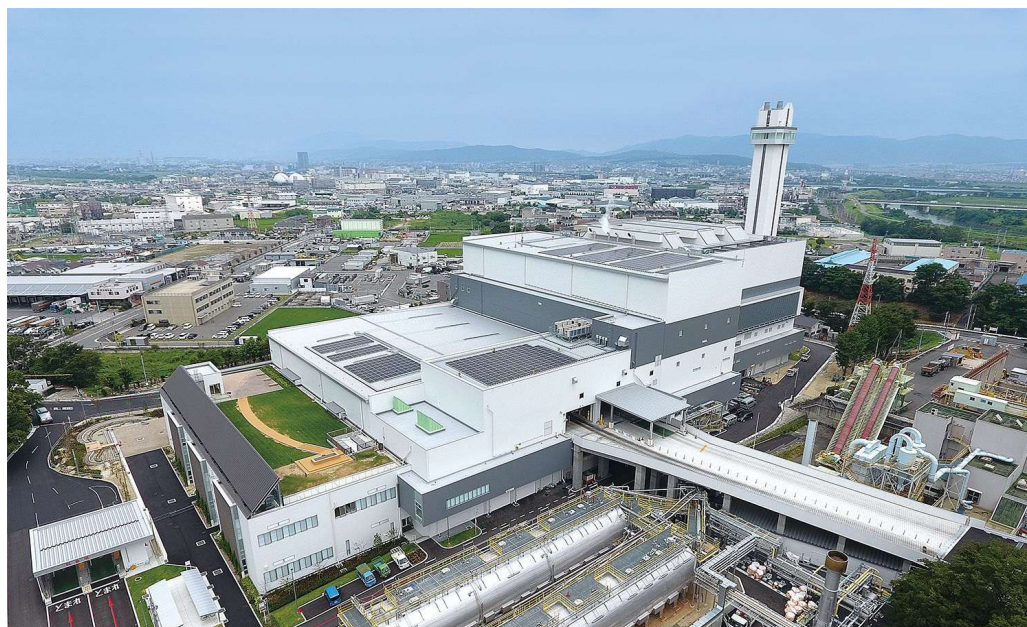
事業完了後(南西上空から撮影)
