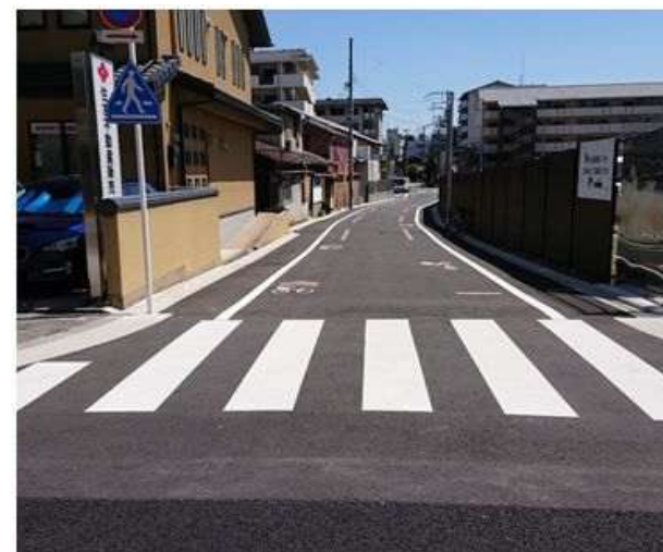
拡幅工事後（平成29年11月共用開始）
