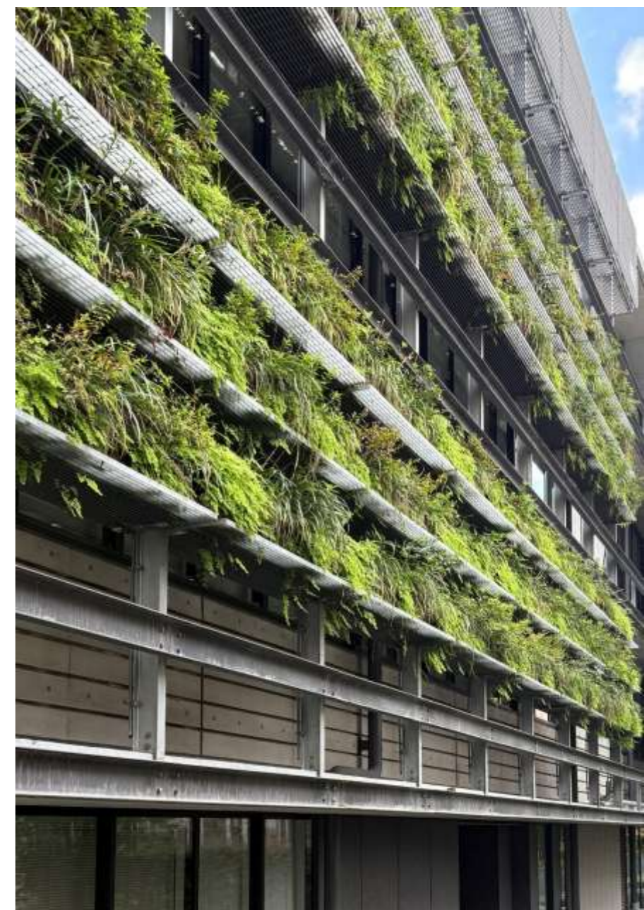
京都市役所分庁舎の壁面を彩るみどり（撮影／みどり政策推進室 2025年）
