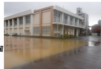
雨水貯留浸透施設(校庭貯留)
