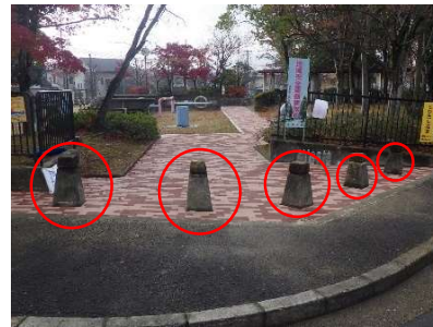
公園出入口の工作物を明るく！ （出入口は公園内計4箇所）
