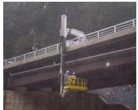
図 6.1 定期点検の様子
