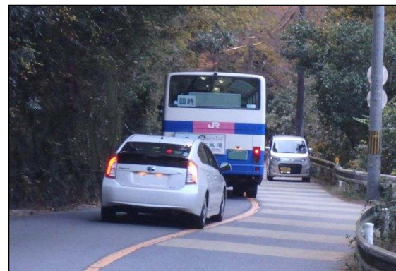
<写真④> 現道(国道162号)の線形不良・幅員狭小箇所
