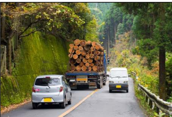
<写真②> 現道(国道162号)の線形不良・幅員狭小箇所
