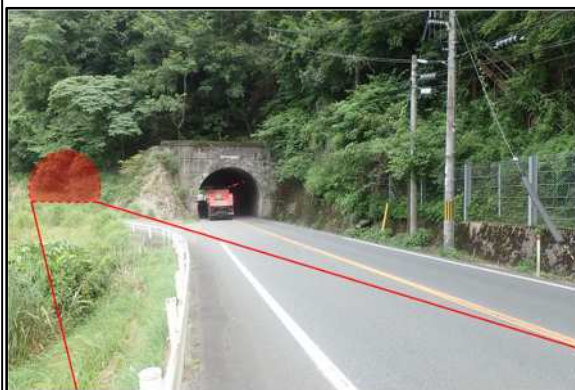
写真③（第2トンネル）
