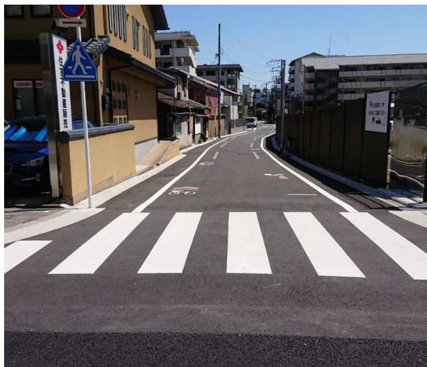
拡幅工事後（平成29年11月供用開始）
