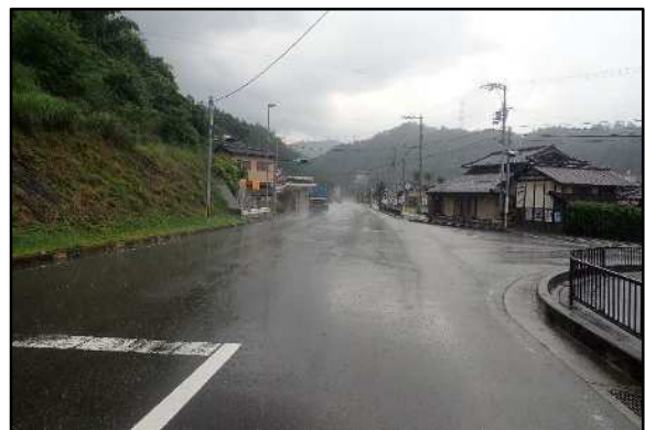
写真④（未整備区間終端付近）
