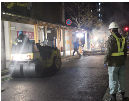
幹線道路の舗装の補修
