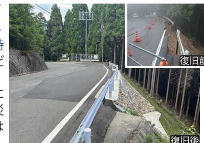
復旧後 国道477号
