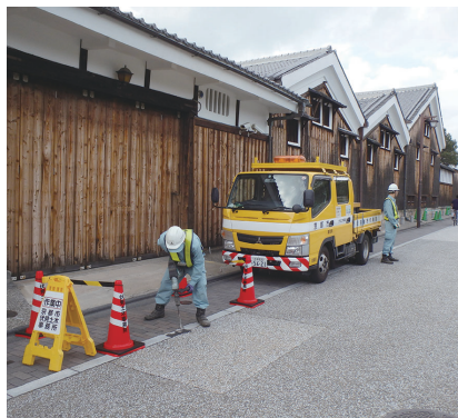
パトロールを通じた道路補修
