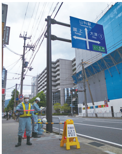
小規模附属物（道路標識等）の点検
