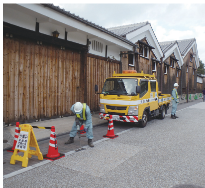
パトロールを通じた道路補修
