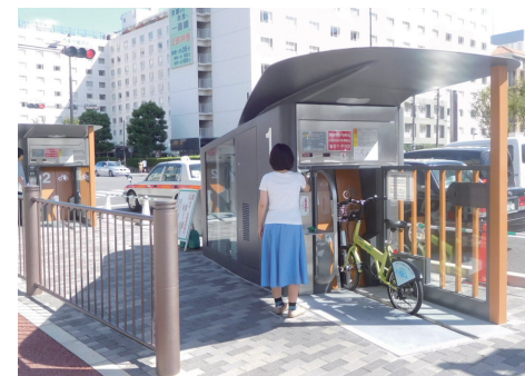
京都駅八条口西自転車駐車場(機械式地下駐輪場)
