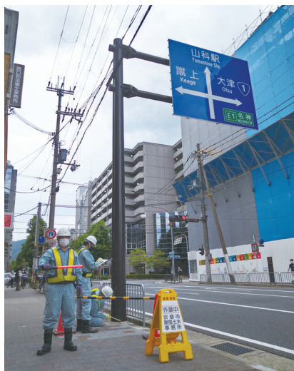
小規模附属物（道路標識等）の点検
