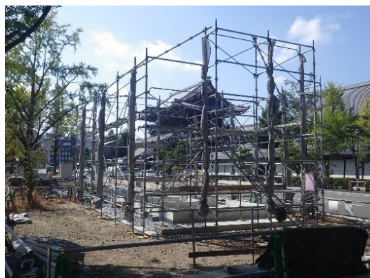
屋外トイレ工事仮設足場
