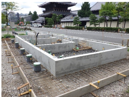
屋外トイレ基礎工事
