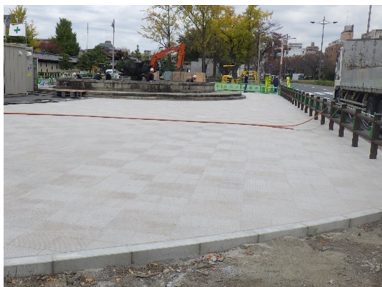
インターロッキング舗装
