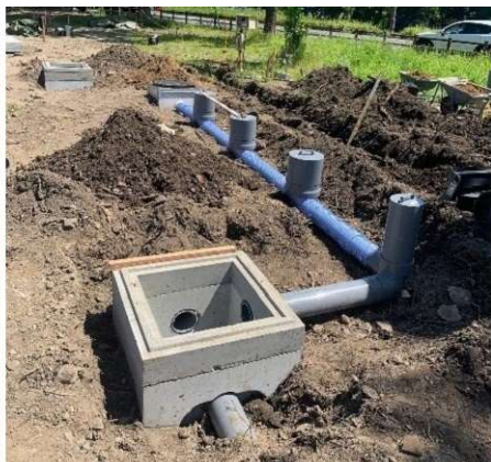
マンホールトイレ、排水枡工事
