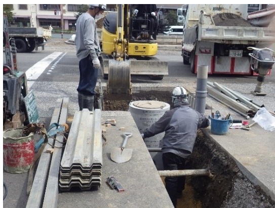
下水道の接続
