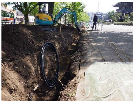
電気管路の敷設
