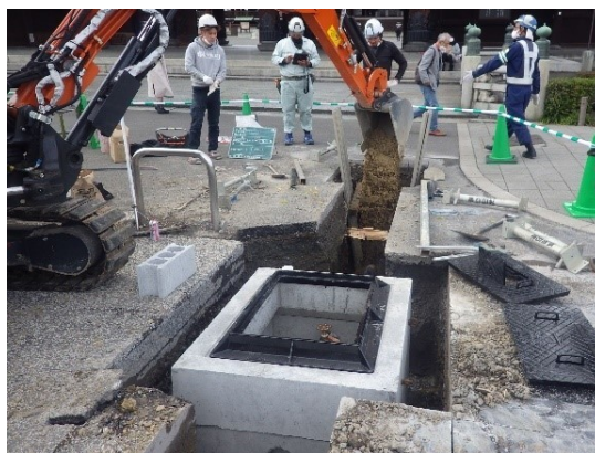
上水道の接続
