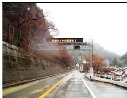
門型標識（道路標識（道路情報提供装置）） （国道 162 号）
