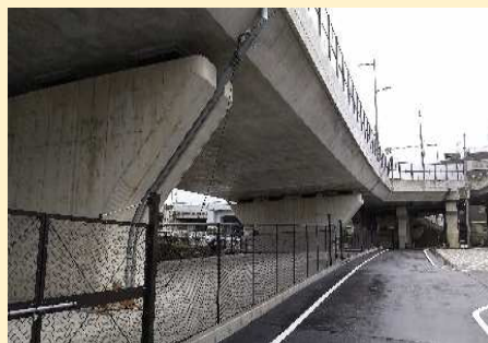
高架下ヤード (鴨川東岸線高架下)
