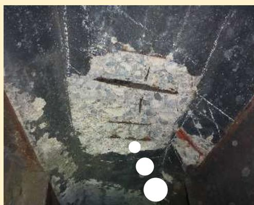
床版コンクリートが剥落し、鉄筋が露出している状況です
