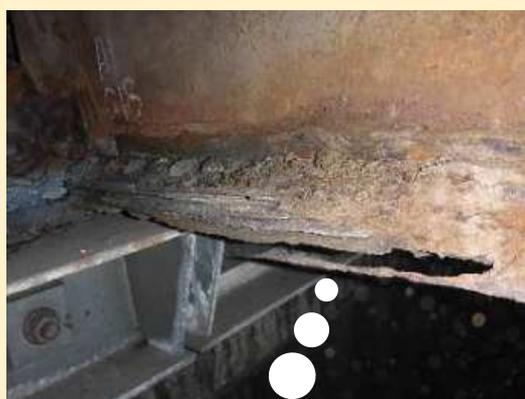
鋼製主桁の一部が腐食によって孔があいている状況です
