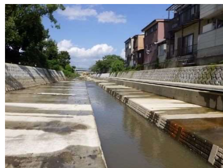
② 承水路整備工事完成区間 （北東方向）
