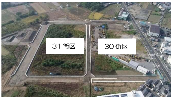
① 横大路淀線等工事区間 （ドローンから南方向）
