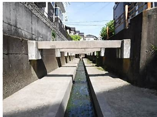
西羽束師川 2-2 号幹線（改修後）
