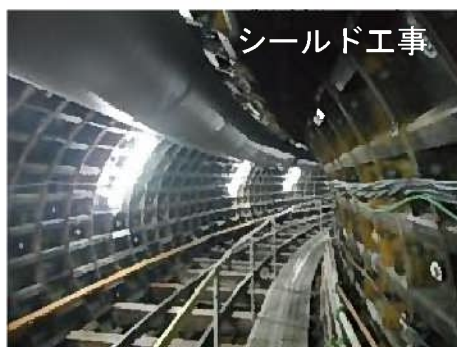
貯留幹線（伏見第3導水渠）
