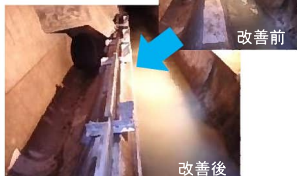
雨水吐の改造（夾雑物対策）
