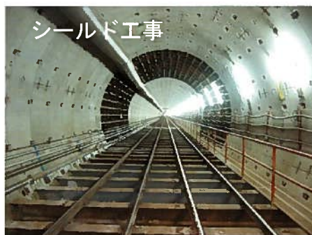
貯留幹線（堀川中央幹線）
