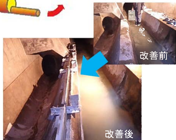
雨水吐の改造（夾雑物対策）
