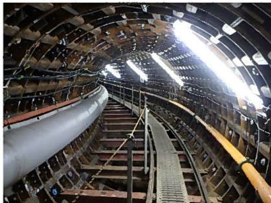
雨水幹線（新川6号幹線）の整備
