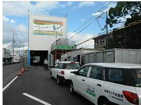
雨水幹線工事ヤード
