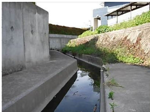
西羽束師川 2-1 号幹線（改修後）
