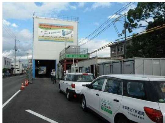
雨水幹線工事ヤード
