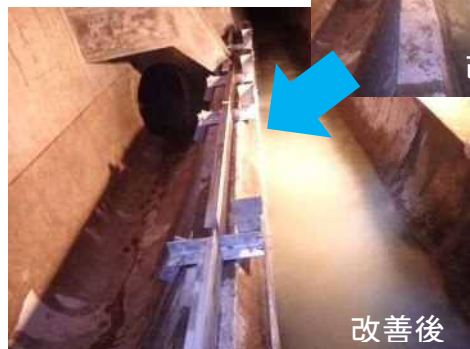
雨水吐の改造（夾雑物対策）
