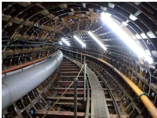
雨水幹線（新川 6 号幹線）の整備
