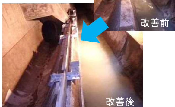
雨水吐の改造（夾雑物対策）
