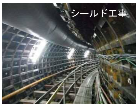
貯留幹線（伏見第3導水渠）
