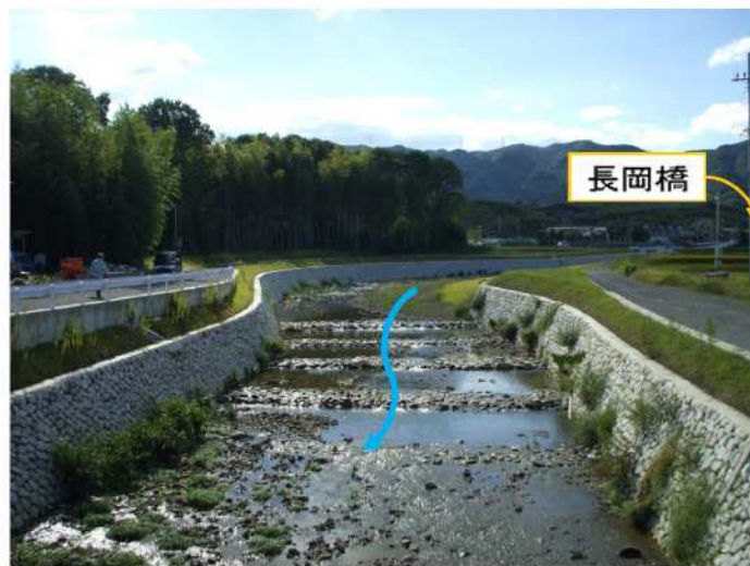
改修済箇所（長岡橋下流）
