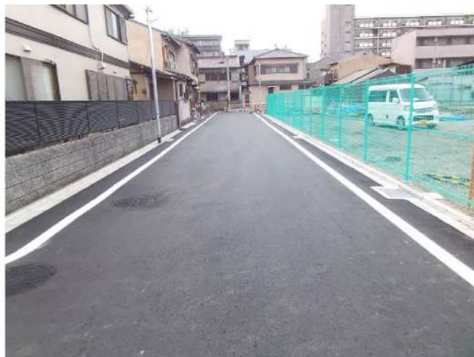
写真③ Bブロック 道路
