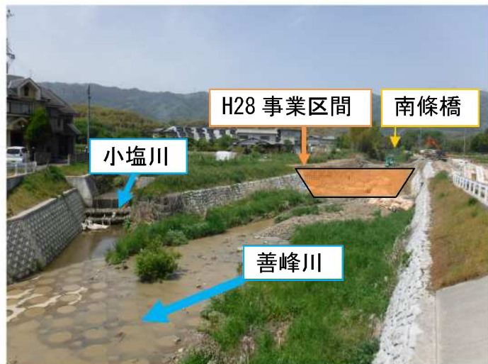
事業中箇所（南條橋下流）
