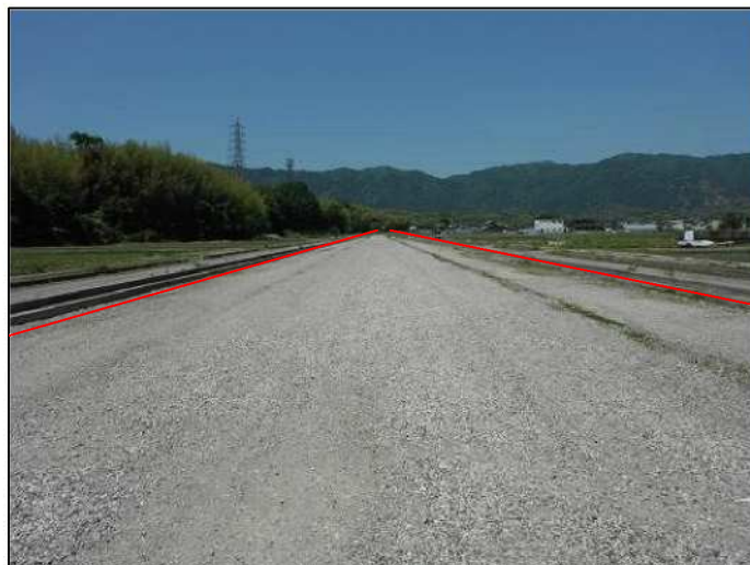
写真②：西工区を東側より撮影
