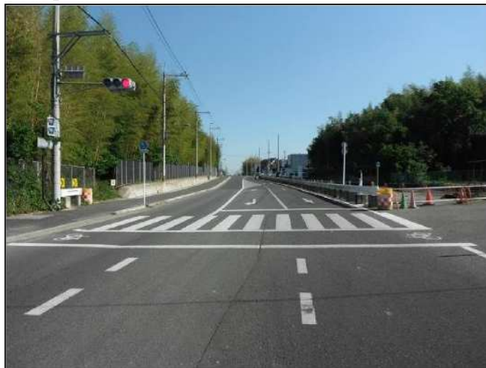
写真③：石見下海印寺線を北側より撮影
