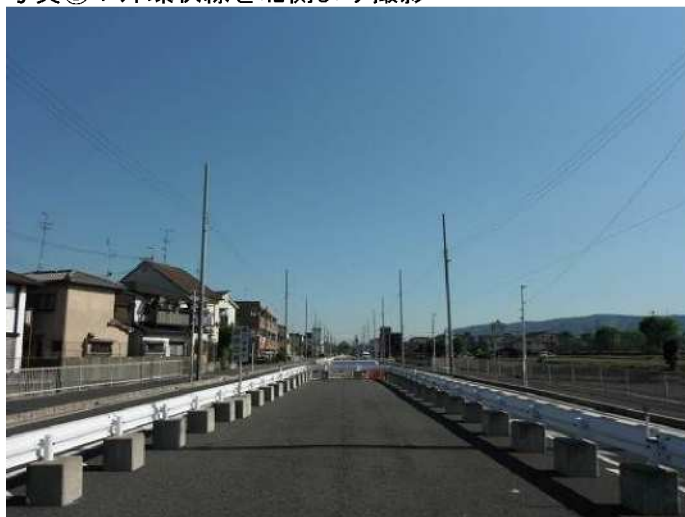
写真③：外環状線を北側より撮影
