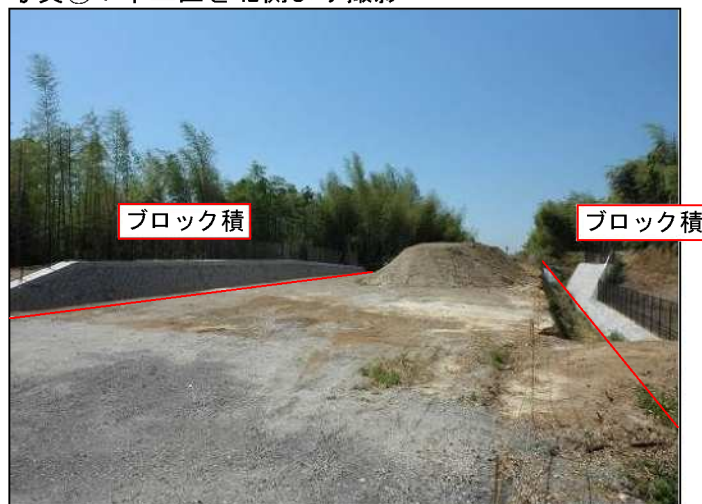
写真②：中工区を北側より撮影
