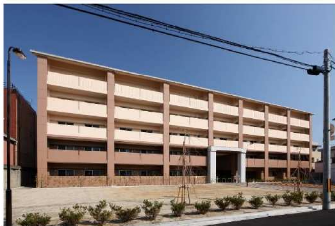
写真② Cブロック 改良更新住宅（東岩本市営住宅1棟）
