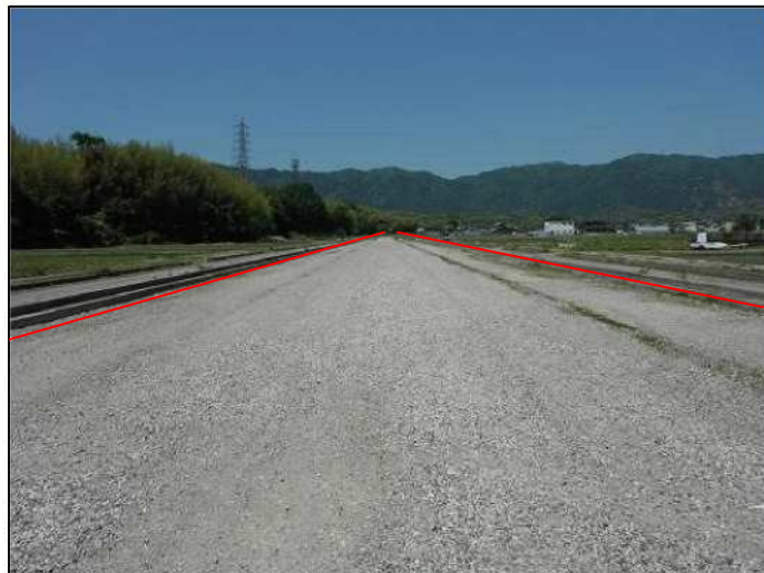
写真②：西工区を東側より撮影
