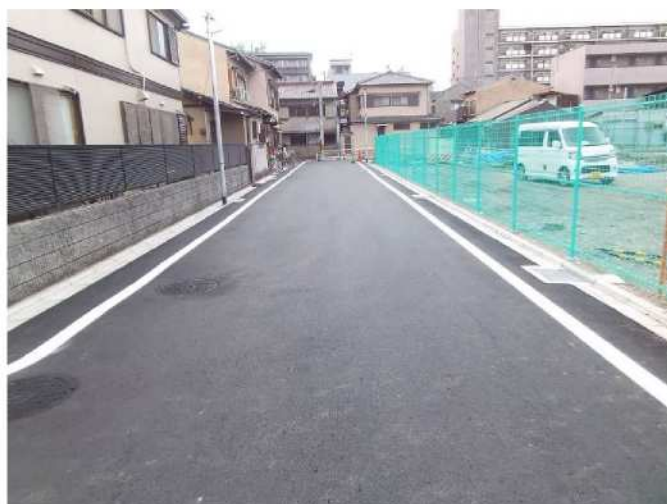
写真③ Bブロック 道路
