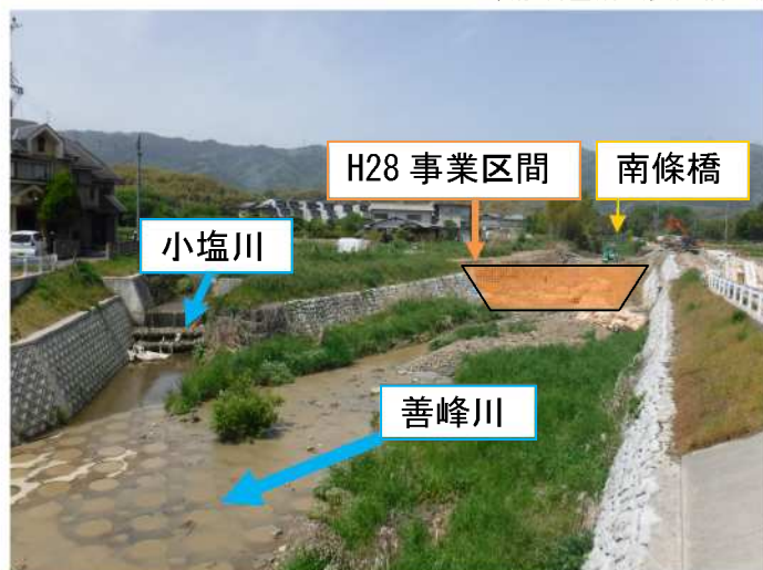
事業中箇所（南條橋下流）
