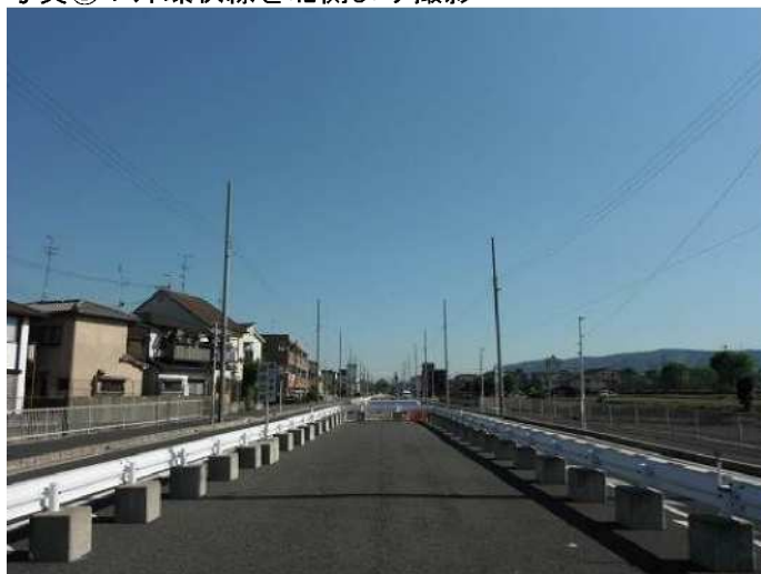
写真③：外環状線を北側より撮影
