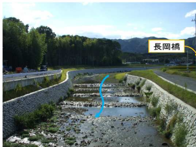
改修済箇所（長岡橋下流）
