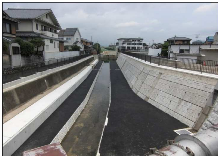
② 承水路整備工事完成区間（納所橋から納所排水機場方向）
