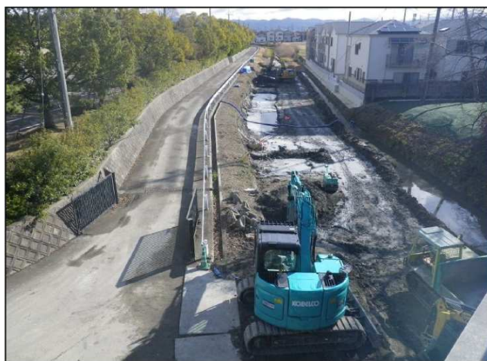
③ 承水路整備工事の状況（J R A車道橋から上流方向）
