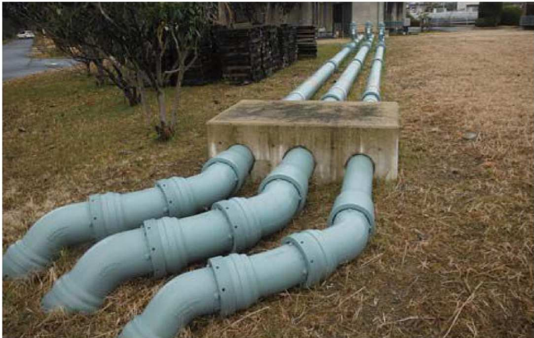
送泥管（石田～鳥羽・伏見～鳥羽）
