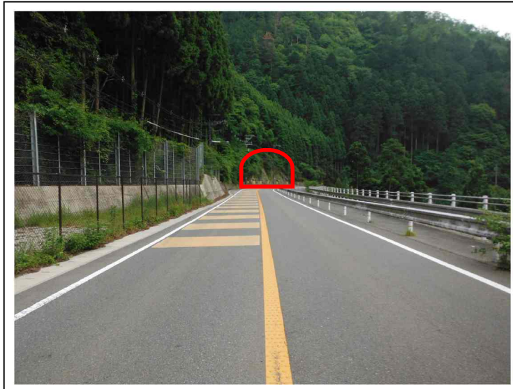
② 第二トンネル 終点側
