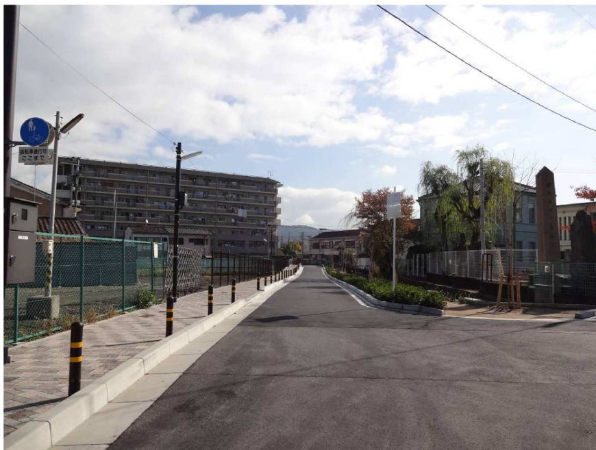
東西道路d（平成24年度完成）を西から望む
