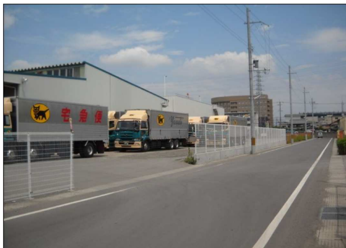
② 区画道路13号築造工事（完成）
