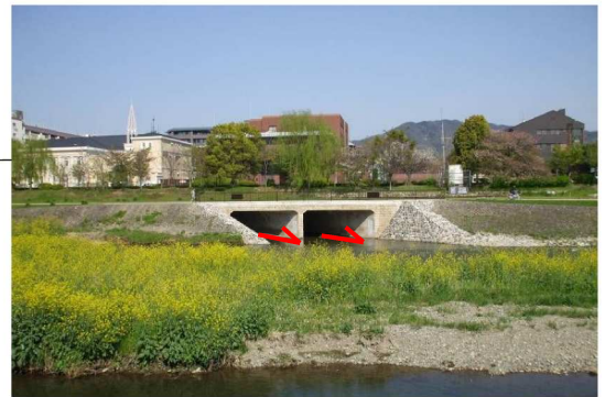
(今出川分水路内部)
