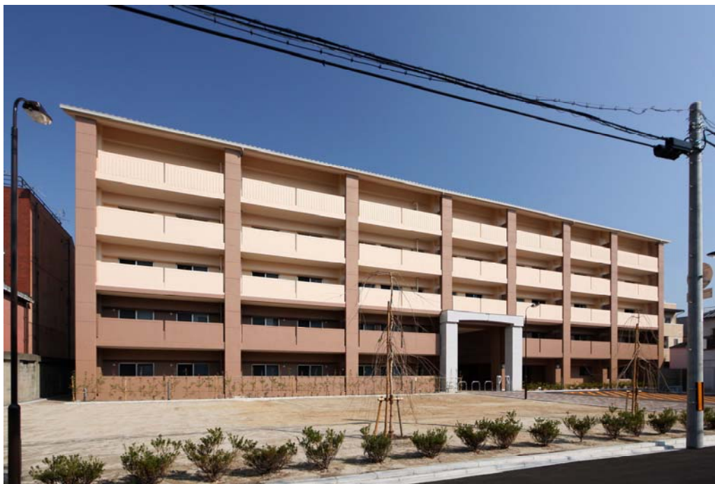
写真③ Cブロック 改良更新住宅（東岩本市営住宅1棟）
