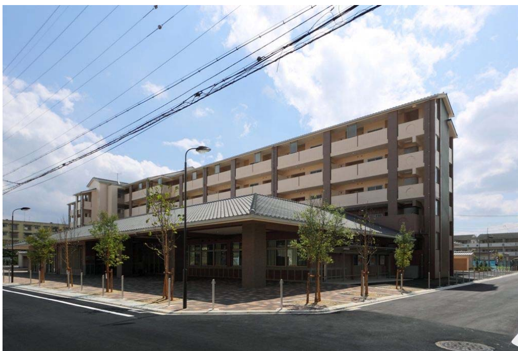
写真④ Dブロック 改良更新住宅（東岩本市営住宅2棟）と 地区施設（地域・多文化交流ネットワークセンター） の合築施設
