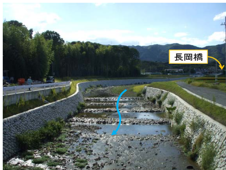
改修済箇所（長岡橋下流）
