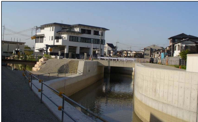
②納所排水機場（完成）・洛南承水路
