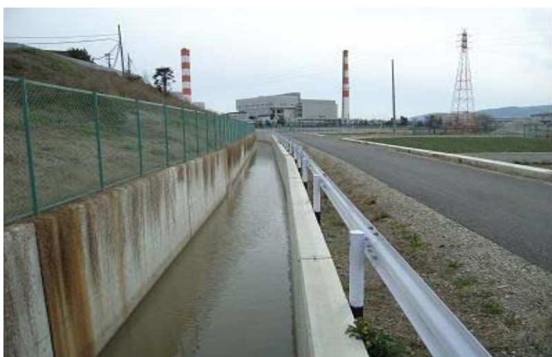
② 洛南承水路（完成）
