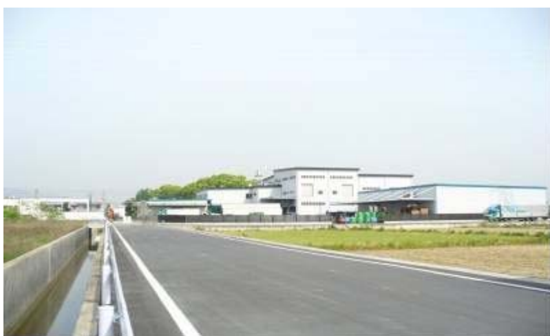
③ 大型物件（移転完了）
