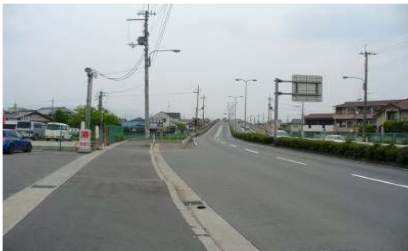
① 外環状線（本線完成）
