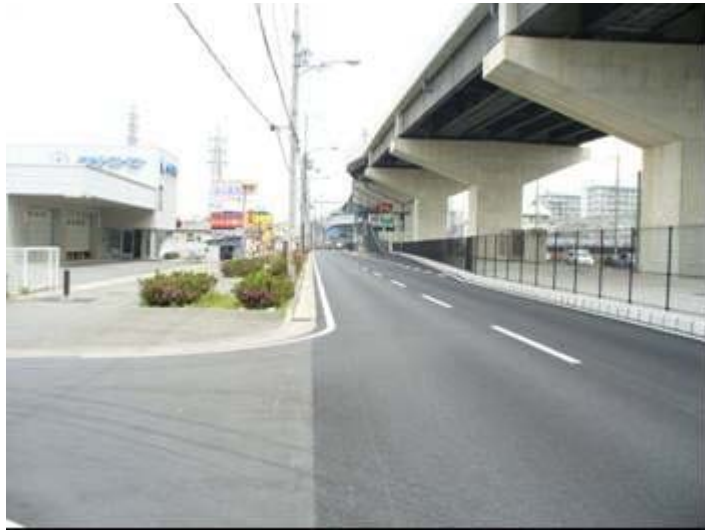
油小路通 北行線 (完成)
