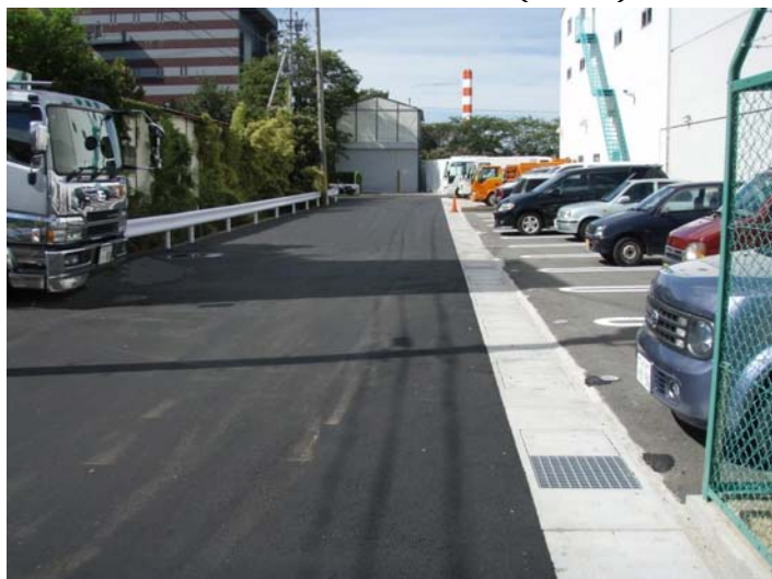
区画道路 51 号線築造工事 (完成)
