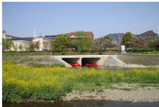
(今出川分水路内部)
